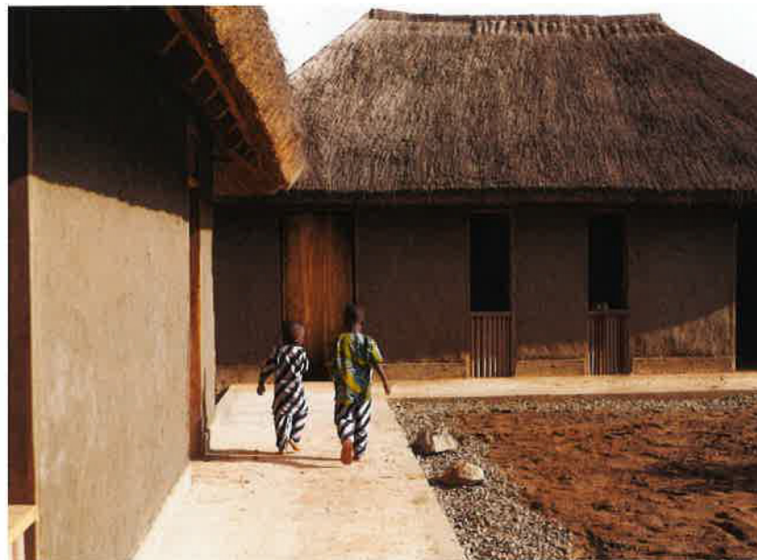
Centre d'accueil pour enfants, Sowé, Bénin. Bauge, terre et chaume. L'Harmattan architecture, 2019.
