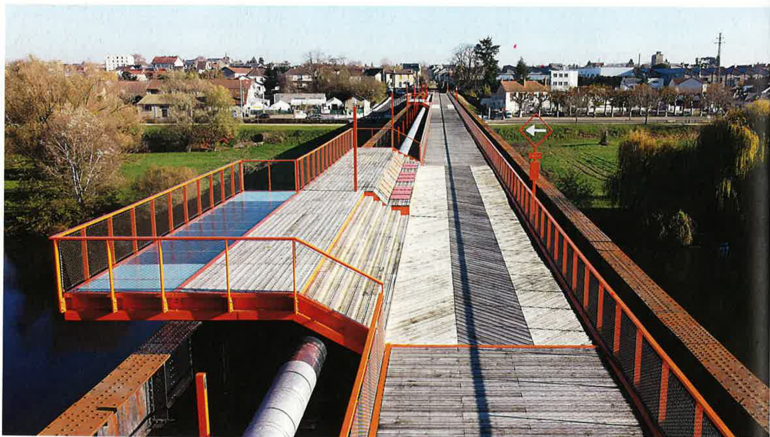
Le belvédère enjambe la conduite d'eau et les poutres de rives qui bloquent la vue sur le paysage.
