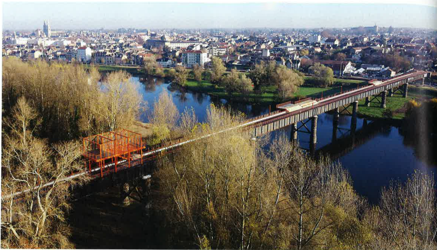
La promenade sur la passerelle est scandée par trois éléments qui instaurent un rapport particulier au paysage et incitent le passant à faire une halte.
