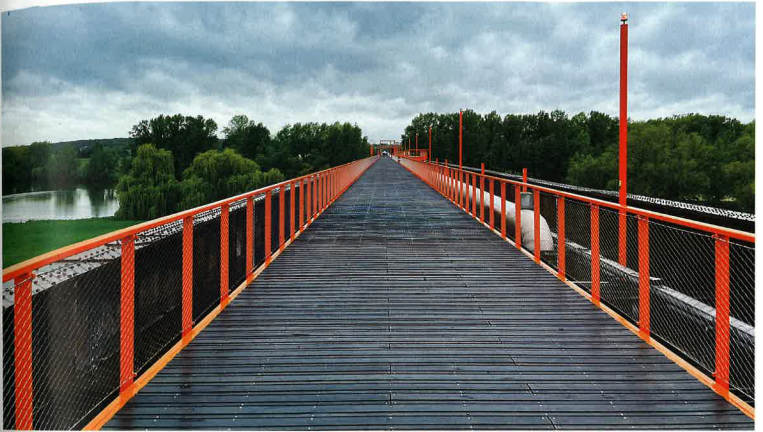
La passerelle ne se déploie que sur une partie du tablier du Pont de fer.
